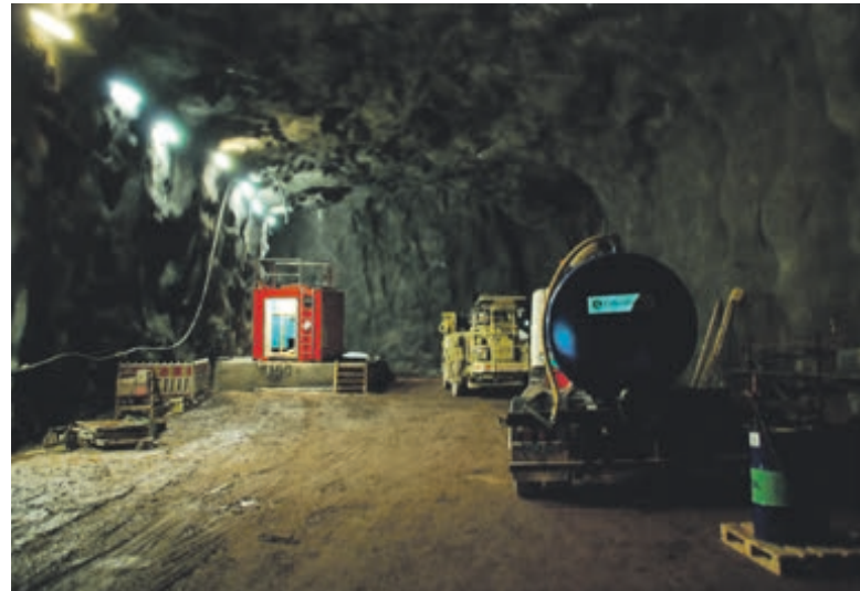
Metroaseman tunnelissa oli runsaasti ajoneuvoja ja erilaisia laitteita.
