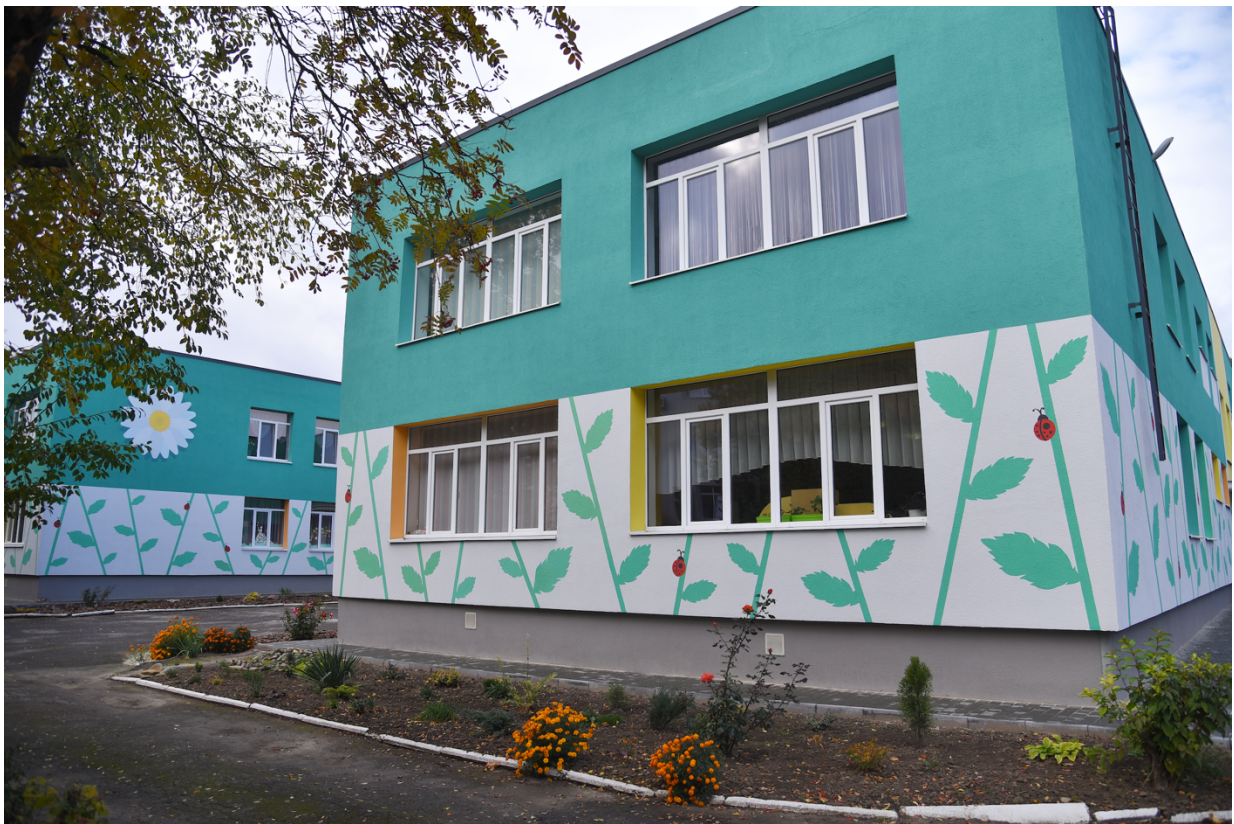
Kuva 2: Nefco on rahoittanut mm. Lutsk'ssa Ukrainassa energiatehokkaita ja modernisoituja päiväkoteja, kouluja sekä kulttuuri- ja urheilutiloja, jotka vähentävät merkittävästi lämmön ja sähkön kulutusta sekä CO 2 -päästöjä.
